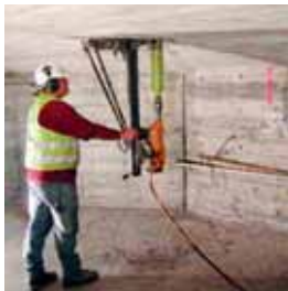
Bohrungen für Endverankerungen
