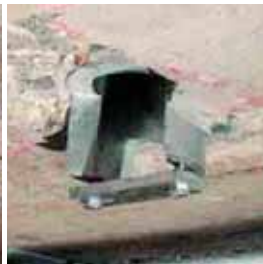
Montieren der beweglichen und festen Verankerung
