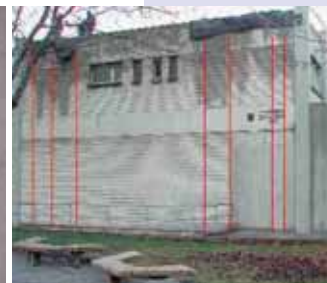
Feuerwehrlokal, Visp: Erdbebenverstärkung
