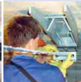
Einhängen Spannglied bewegliche Verankerung
