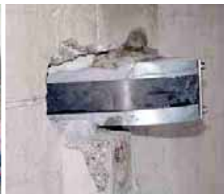
Reussbrücke, N4 Flüelen: Querträgerverstärkung
