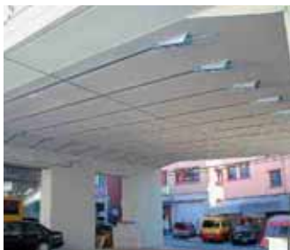
Sung San Bridge, Korea: Erhöhung der Trag- sicherheit
