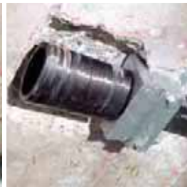
Einhängen Spannglied feste Verankerung
