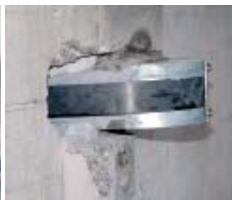
Pont sur la Reuss, N4 Flüelen: renforcement des entretoises
