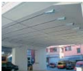
Pont de Sung San, Corée: augmentation de la sécurité structurale
