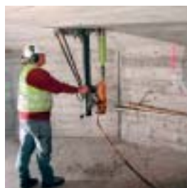
Perçages pour Les ancrages finaux
