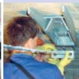
Fixation de l'élément de traction à l'ancrage mobile
