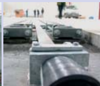
Usines Audi, Hongrie: renforcement du radier
