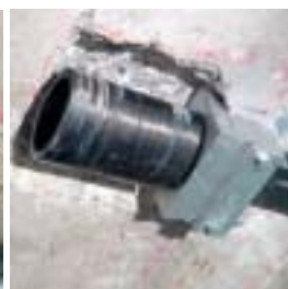
Fixation de l'élément de traction à l'ancrage fixe
