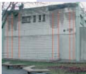
Local des pompiers, Viège: renforcement aux séismes
