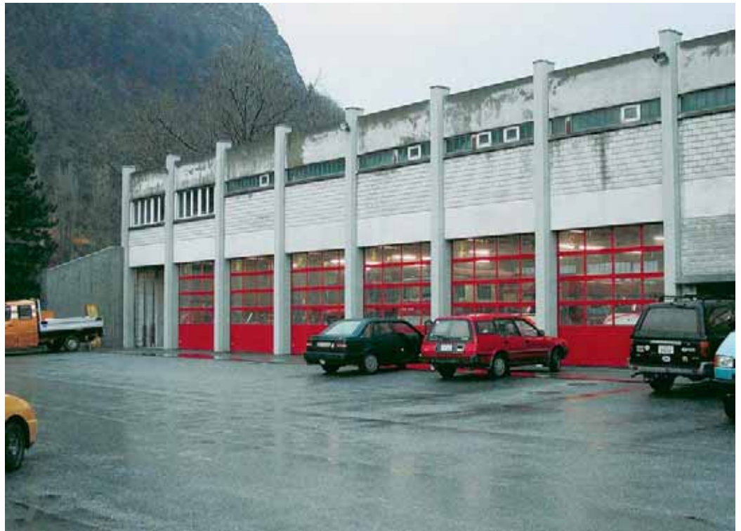
Das Gebäude der Feuerwehr Visp wurde nachträglich erdbebensicher umgerüstet.
