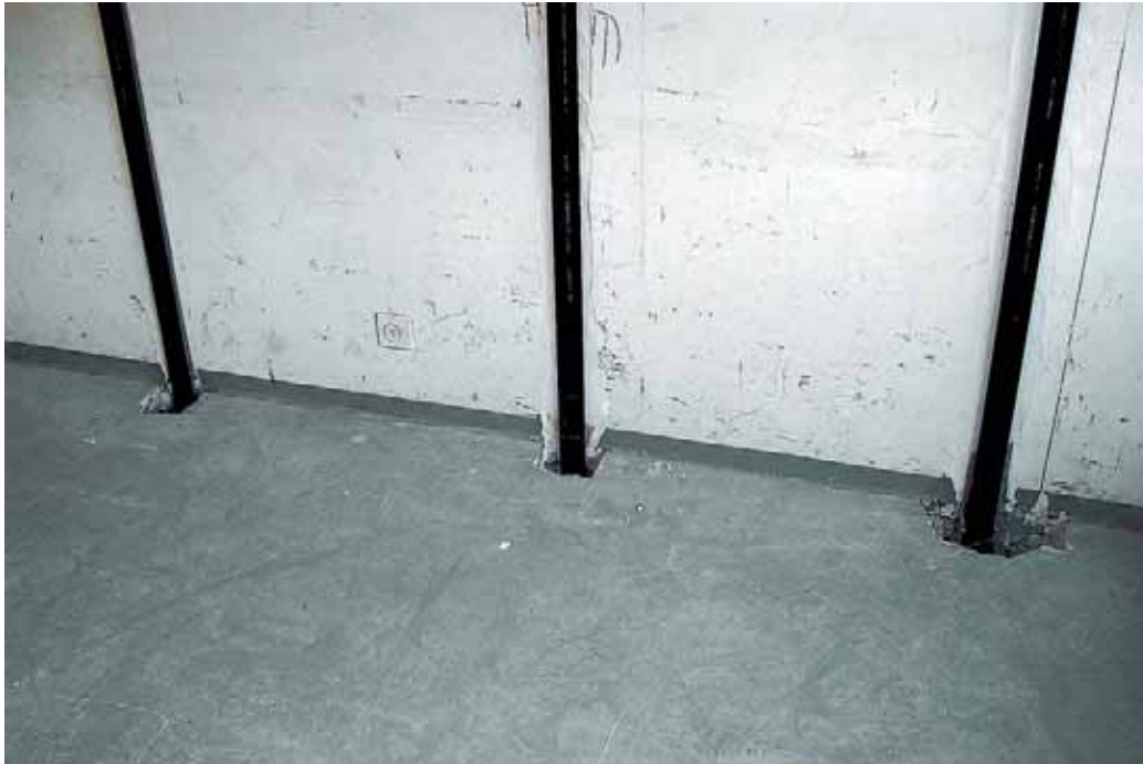
Die Lösung mit vertikal angeordneten, vorgespannten CFK-Lamellen stellte sich als optimal heraus. Im Bild die Ansicht der Giebelwand mit CFK-Lamellen.
