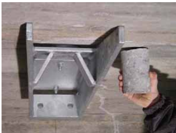
Abb. 14: Versetzen der beweglichen Verankerung (Typ III)
