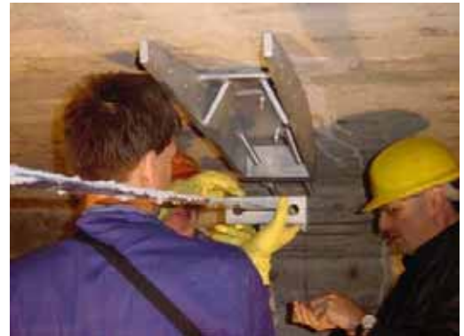
Abb. 17 : Einsetzen des Spanngliedes in die bewegliche Verankerung (Typ III)
