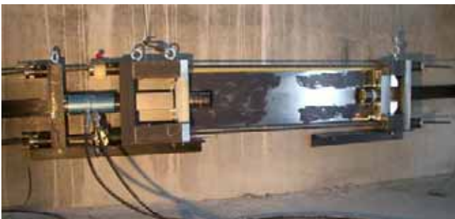
Abb. 23: Siloverankerung im Spannzustand
