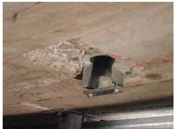
Abb. 15: Versetzen der festen Verankerung (Typ III)
