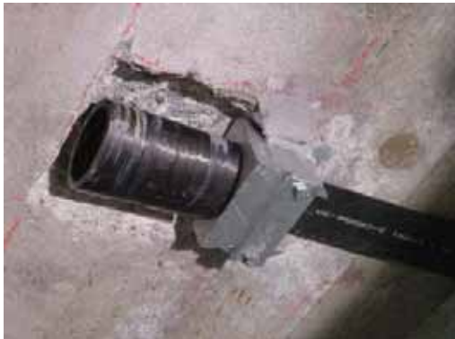
Abb. 16 : Einsetzen des Spanngliedes in die feste Verankerung (Typ III)
