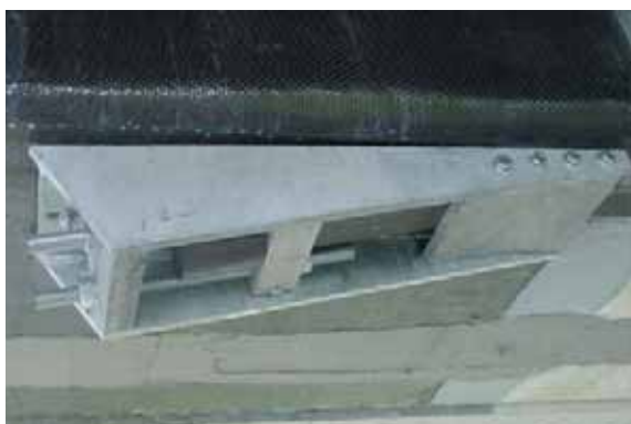
Abb. 19: Definitive bewegliche Verankerung (Typ III)
