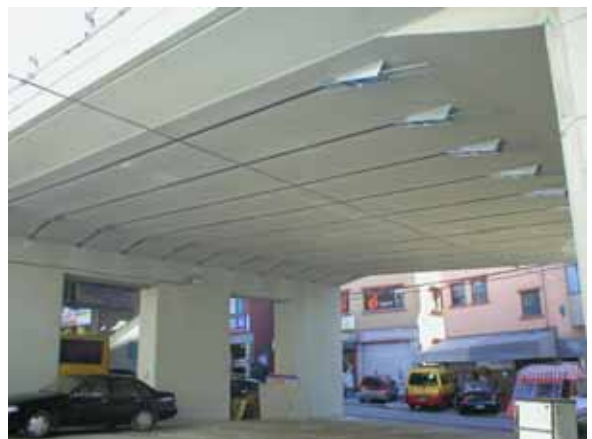
Abb. 9: Anwendung: Brückenverstärkung Korea
