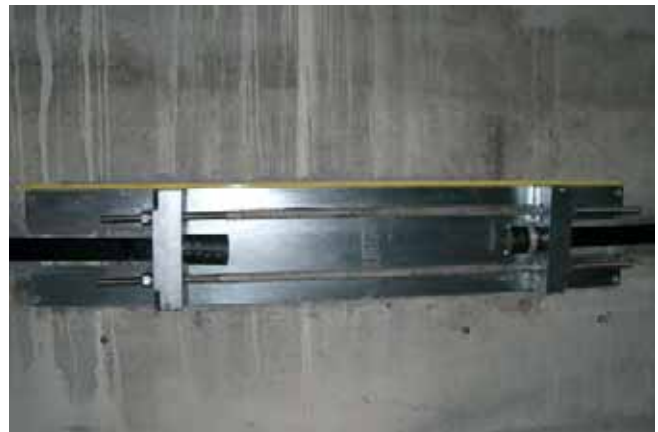
Abb. 24: Siloverankerung im Endzustand
