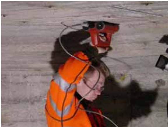
Abb. 12: Bestimmen der definitiven Lage (aufgrund der Bewehrungsanordnung) der Kernbohrungen
