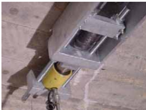
Abb. 18: Spannen des Spanngliedes
