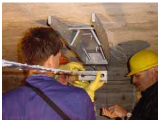
ill. 17: mise en place de l'ensemble de précontrainte dans l'ancrage mobile (type III)
