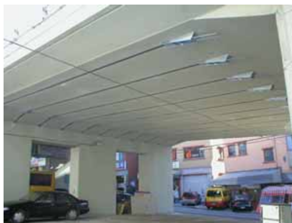
ill. 9 : renforcement d'un pont en Corée
