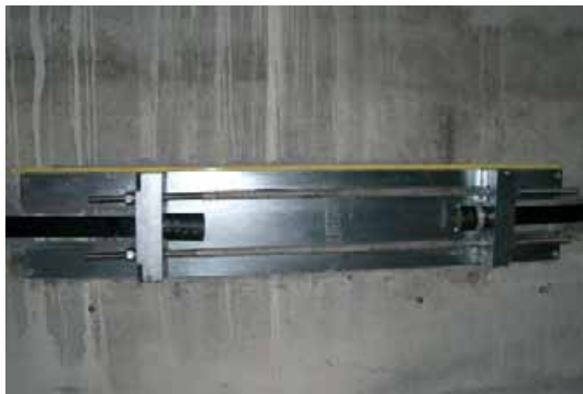
ill. 24: ancrage de silo terminé
