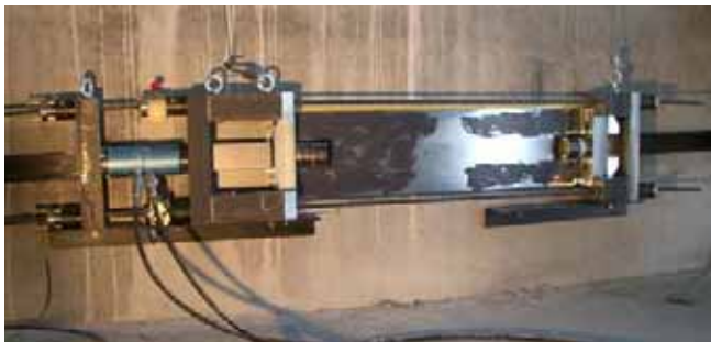
ill. 23: ancrage de silo en position de tension
