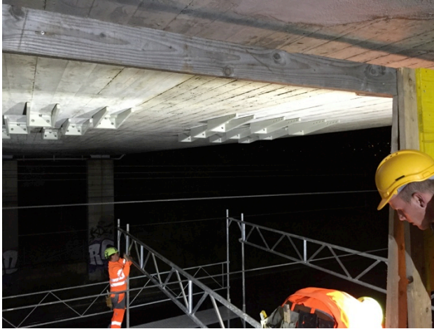
Abb. 01: Aufbau des mobilen Gerüstes
