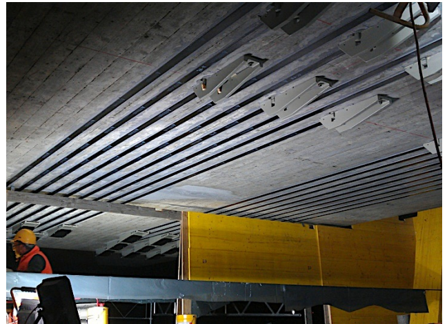
Abb. 02: Gespannte StressHead-CarboStress® Systeme
