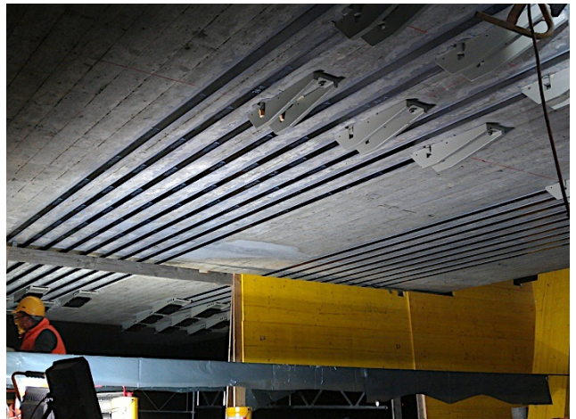
Abb. 02: Gespannte StressHead-CarboStress ® Systeme
