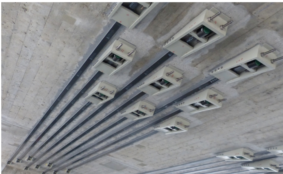
Abb. 03: Gespannte StressHead-CarboStress ® Systeme
