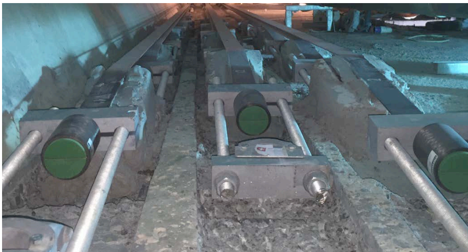
Abb. 04: Gespannte StressHead-CarboStress® Systeme
