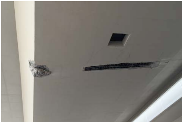
Abb. 01: Beschädigter Hohlkasten
